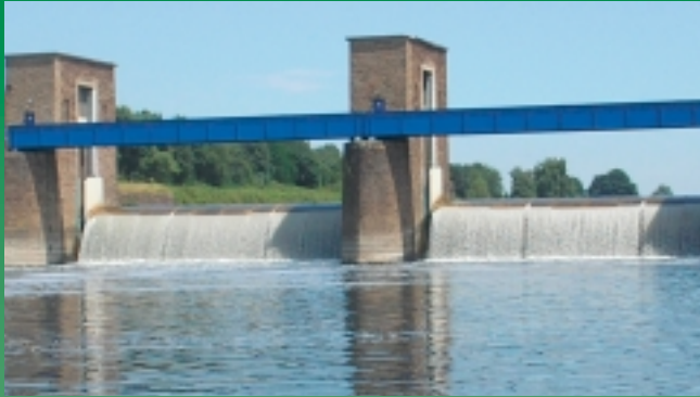
Auch das Ruhrwehr kann von den Fischen dank der Fischaufstiegsanlage überwunden werden.
